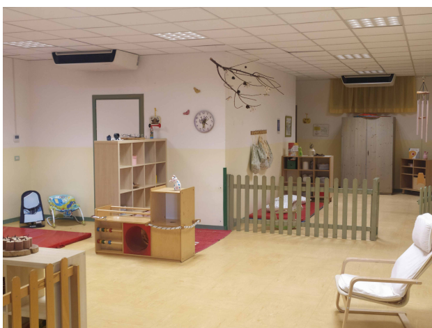
controsoffitto fonoassorbente, lampade a led, impianto di condizionamento e allarme incendio
