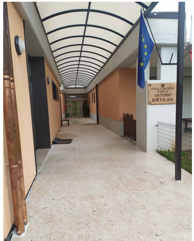
pavimentazione ingresso principale
